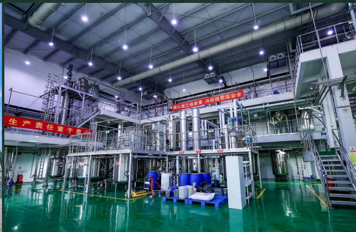
10T级 工业化生产产线
